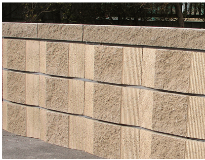
いも積み施工
